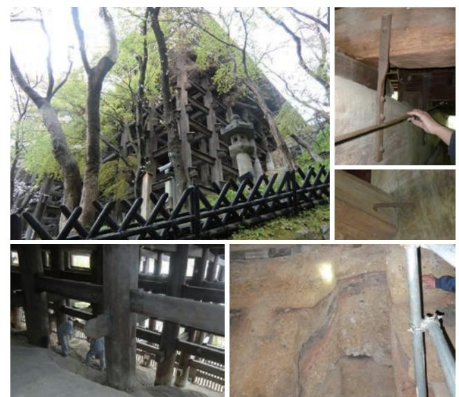
それと右図右上の写真ですが、よく伝統木造は金物を使っていないと解釈されたりしますが、実はたくさん使っています。現在の建築でも使われているような金物の原形を見ることができます。写真では2つしか挙げていませんが、ひねり金物、カスガイ、その他にも、平金物であったり梁受け金物であったりと、現代につながっている様子を見ることができます。
